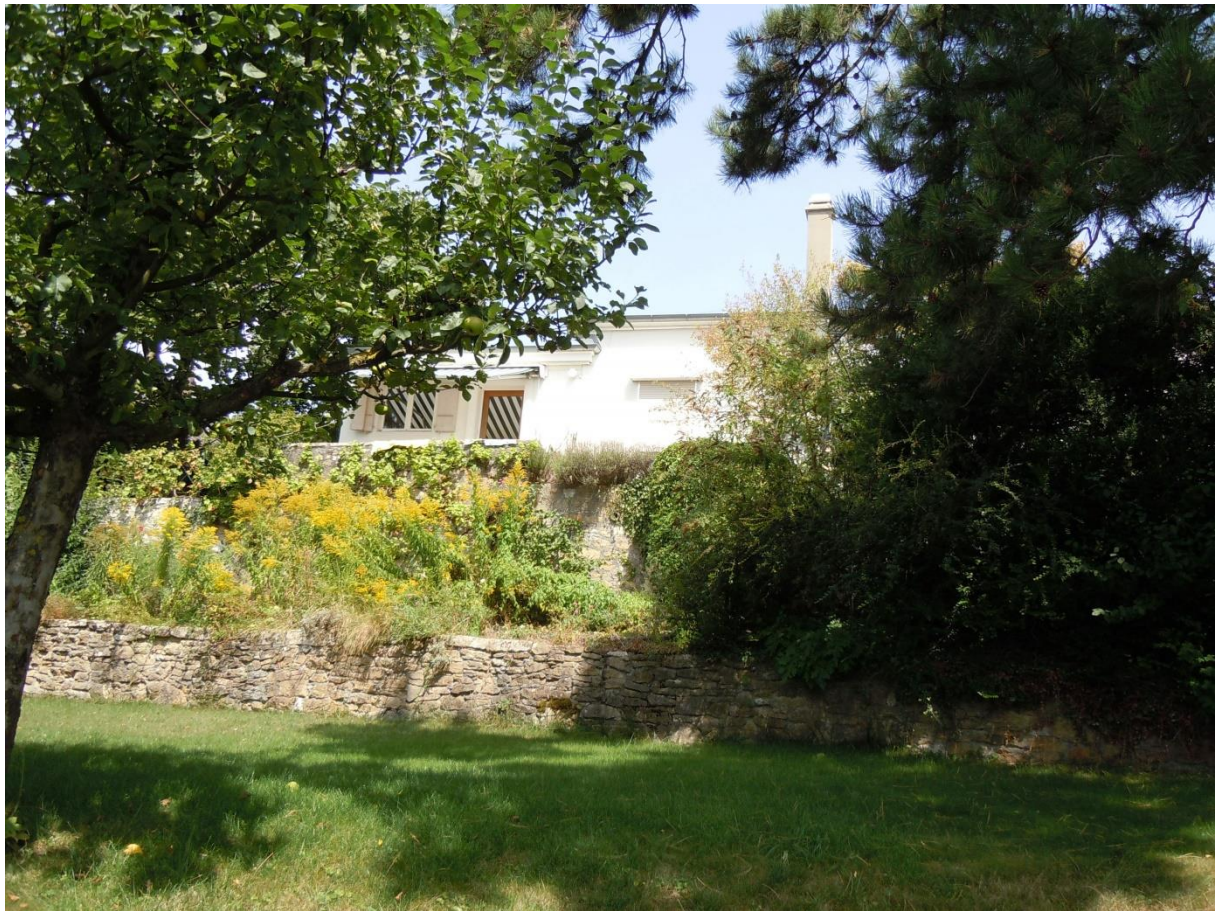
Façade côté du Lac de Neuchâtel
