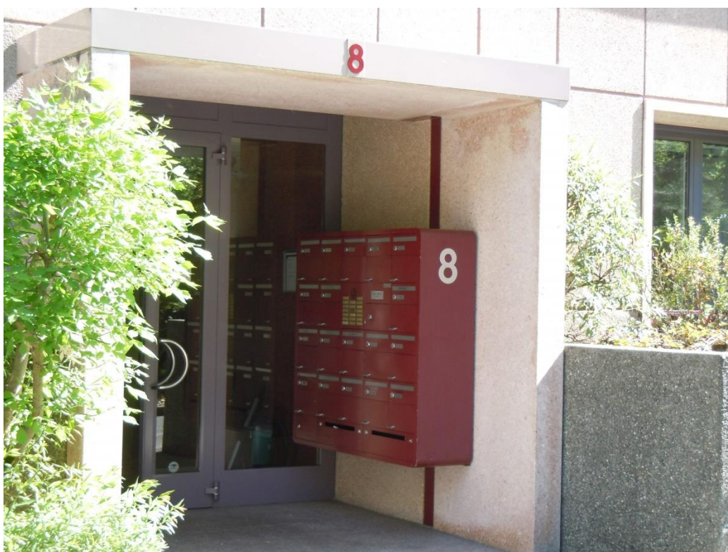
L'entrée de l'immeuble
