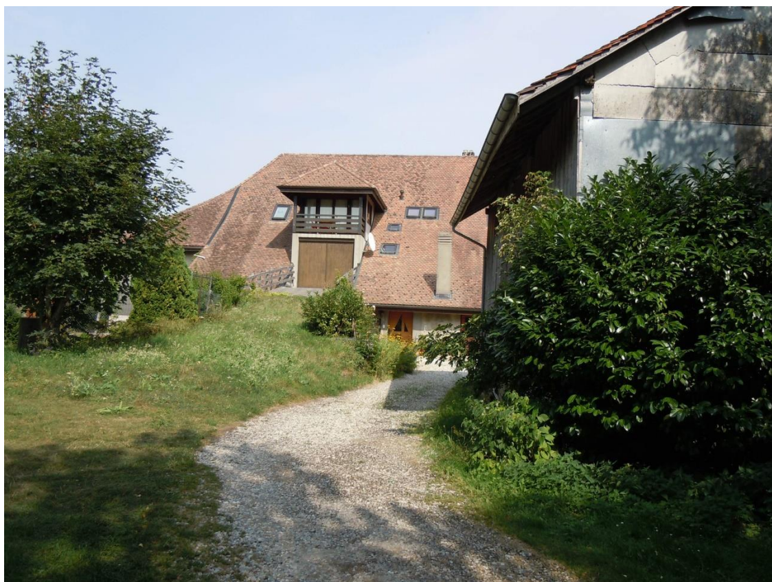
Maison côté ouest
